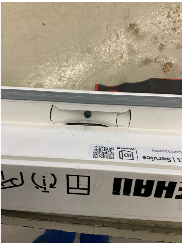
Abbildung V 09-4 Bruchkante
